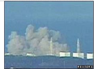
El sistema de refrigeración en la planta nuclear de Japón dejó de funcionar.
