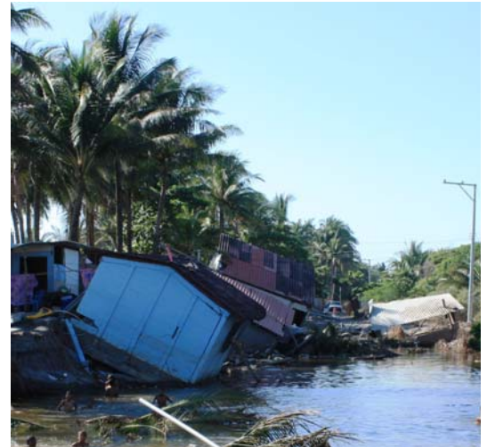
Viviendas dañadas por las fuertes lluvias asociadas al Huracán Ida, El Salvador, octubre de 2009.
